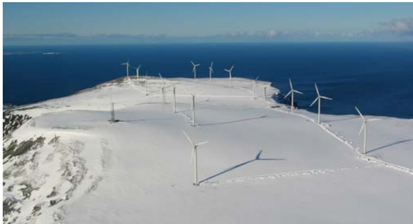
Vindkraftverket i på Havøygavlen.
