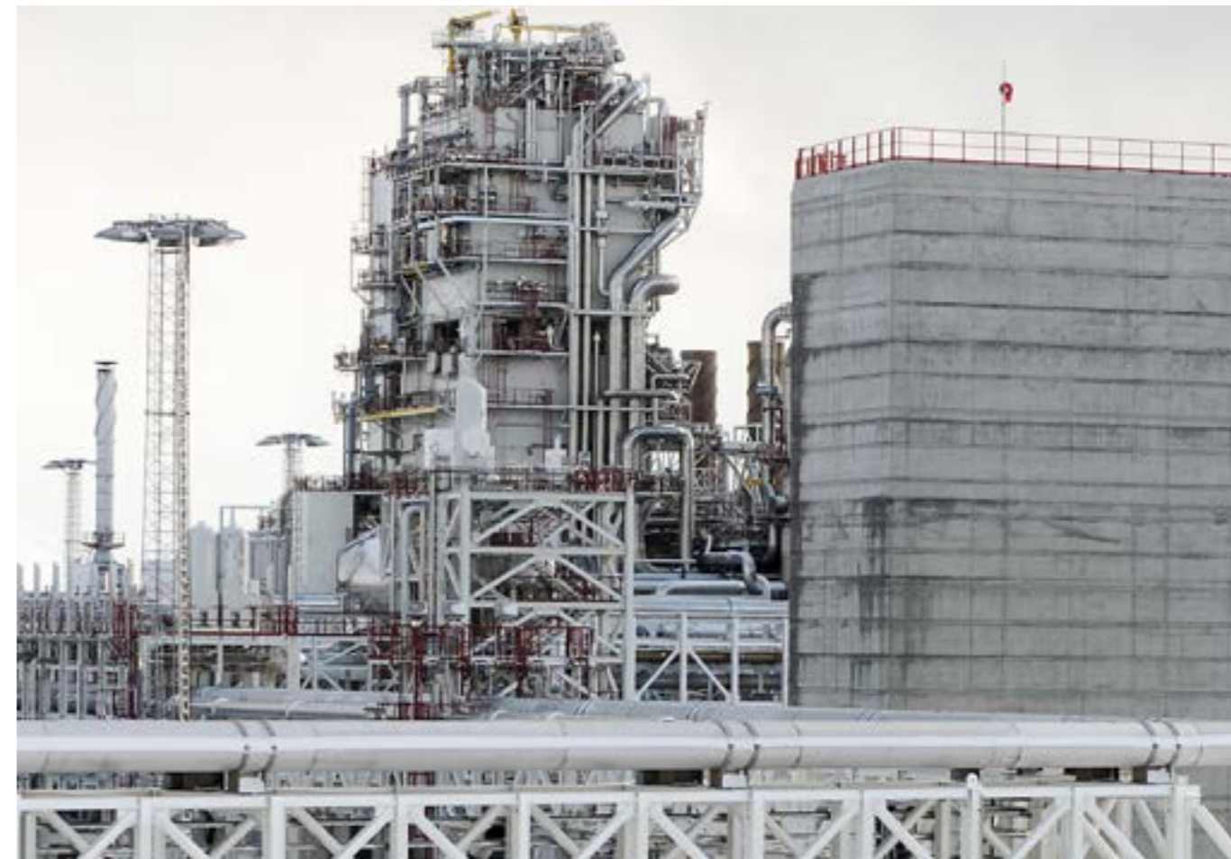
Produksjonsanlegget på Hammerfest LNG, Melkøya.
