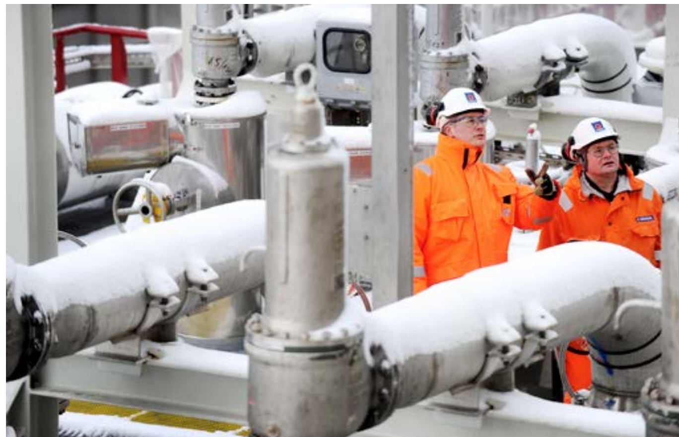
Inspeksjon av produksjonsanlegg, Hammerfest LNG.
