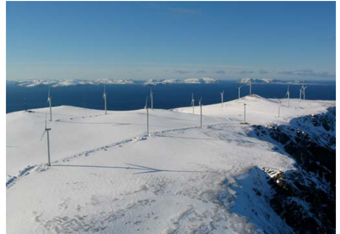
Vindkraftverket i på Havøygavlen.
