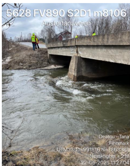
Figur 9-1 Bilde av dagens bru tatt under befarig mai 2025.
