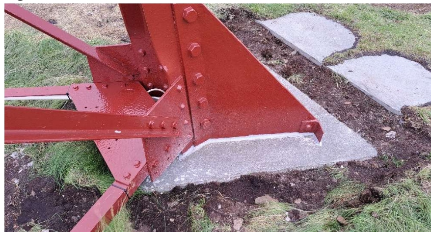
Figur 41: Detalj fra ferdig istandsatt fundament. Stålprofil langs bakken er flyttet opp – se hull fra opprinnelig plassering. Støpt ny overflate på betongfundament, fuget med moderne fugemasse. Foto: FFK
