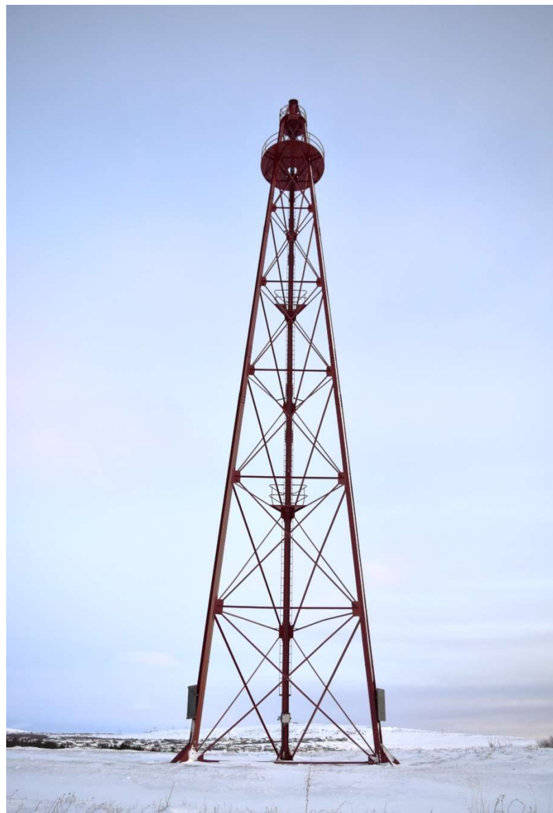
Figur 16: Luftskipsmasta, fasade mot sørvest. Foto: FFK.
