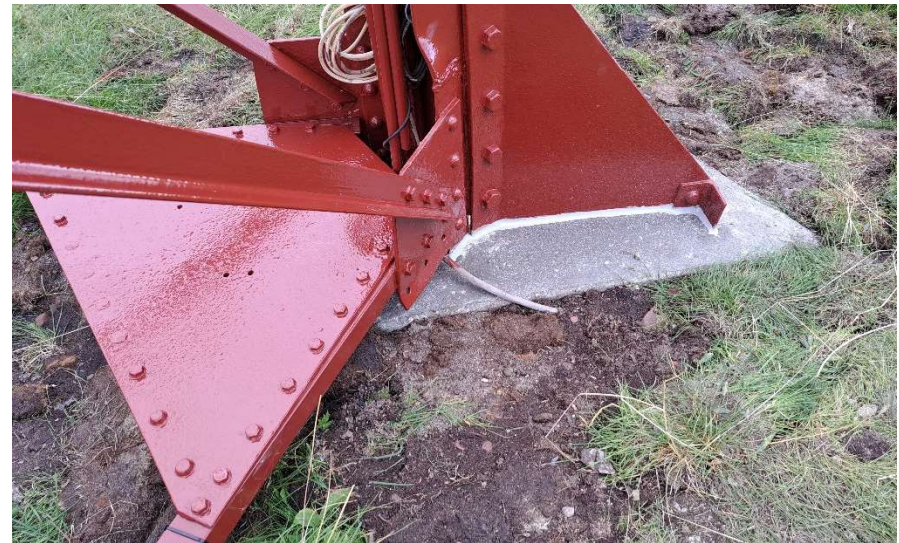
Figur 23: Innfesting til fundament. Foto: FFK.
