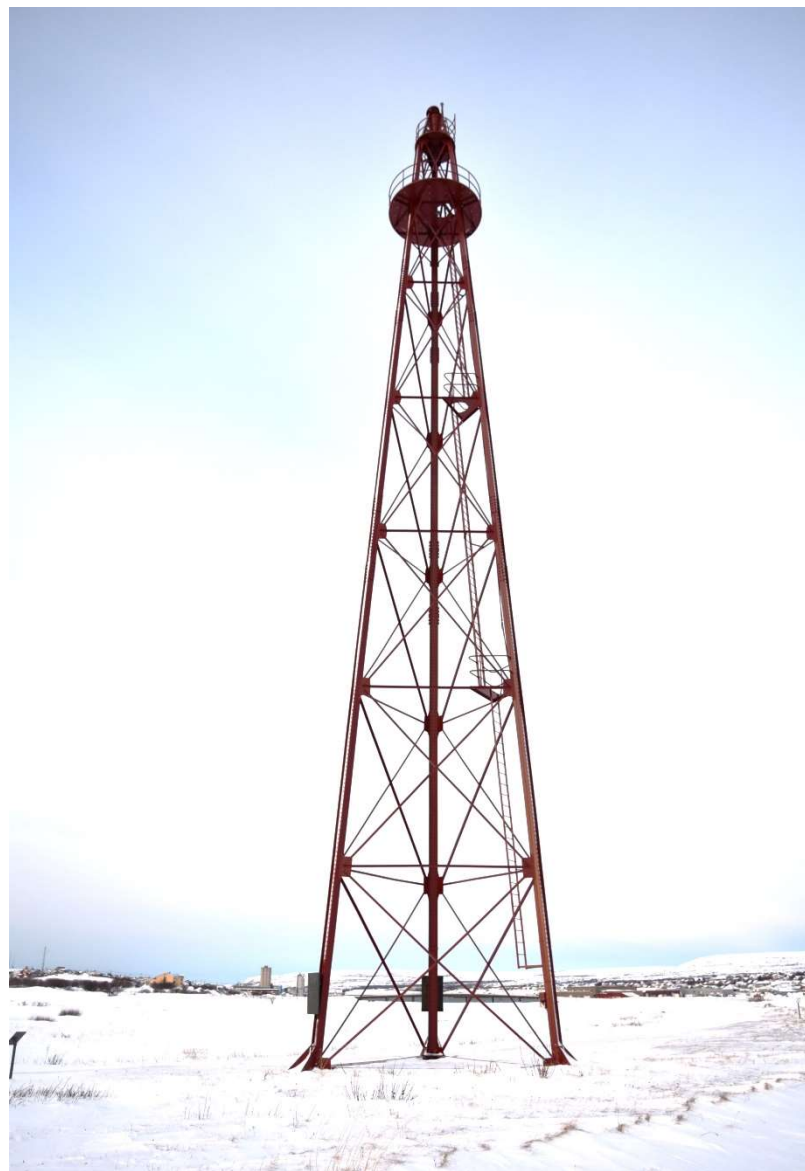
Figur 12: Luftskipsmasta, fasade mot sørøst. Foto: FFK.
