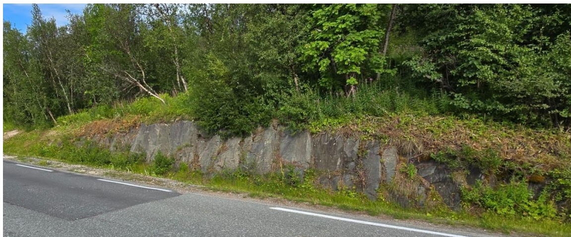
Figur 10-1: Blotning i parsell 1, cirka ved profil 3850. Bildet er tatt mot øst.
