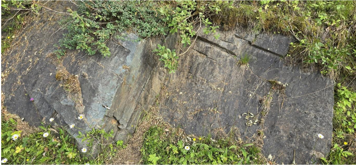
Figur 14-2: Bilde av bergarten, cirka ved profil 1250.
