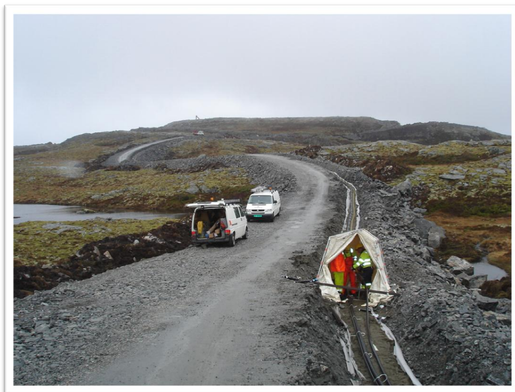
Figur 3-1 Anleggsarbeid, Bessakerfjellet vindkraftanlegg Finnmarkseiendommen (FeFo)
