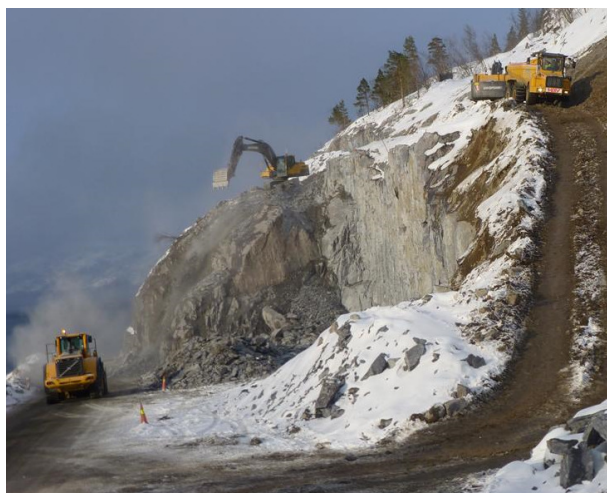
Bygging av ny E6 Alta vest, foto: SVV
