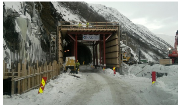
Rassikringsarbeid ved Øksfjordtunnelen. Foto: SVV
