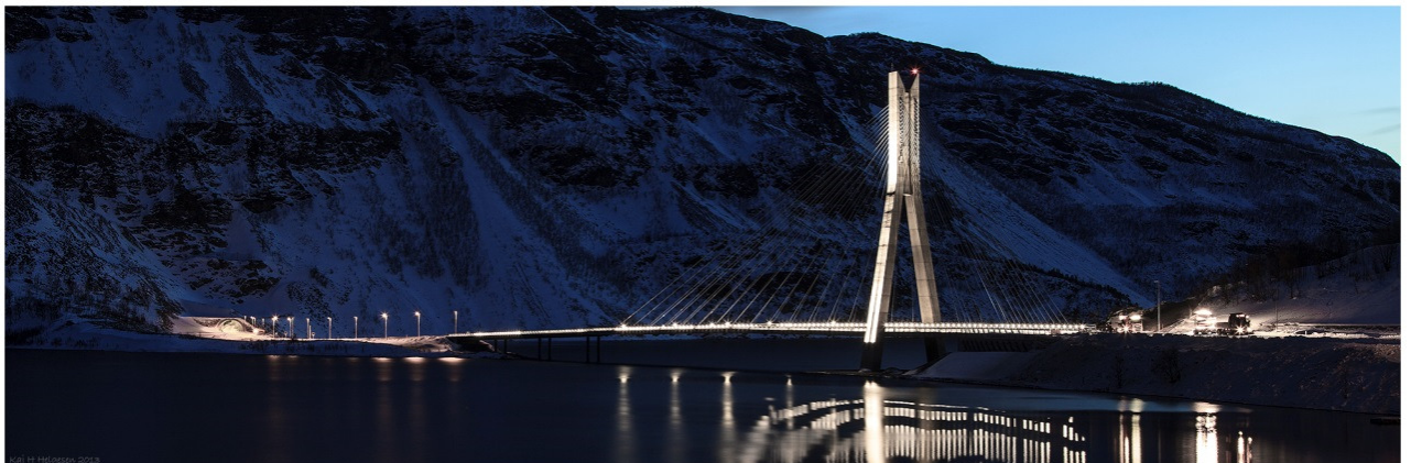
Kåfjordbrua E6, foto: SVV
